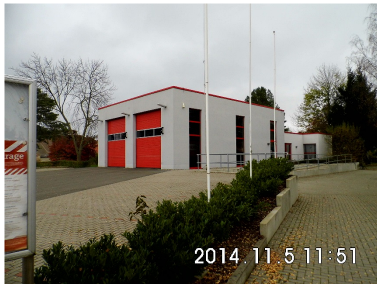
Bild 12 - Ansicht des Feuerwehrhauses Klein Schierstedt
