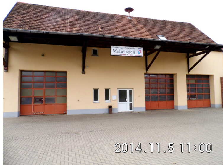
Bild 13 - Ansicht des Feuerwehrhauses Mehringen
