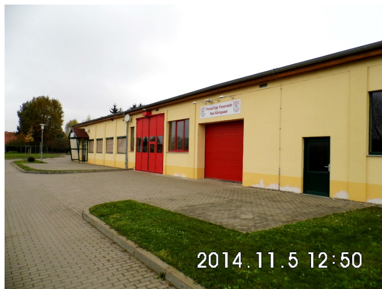
Bild 14 - Ansicht des Feuerwehrhauses Neu Königsau
