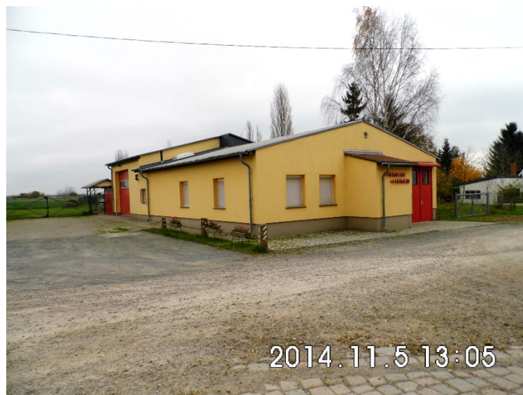
Bild 17 - Ansicht des Feuerwehrhauses Wilsleben
