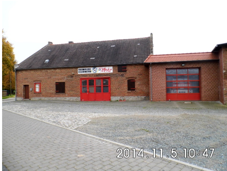
Bild 5 - Ansicht des Feuerwehrhauses Drohndorf
