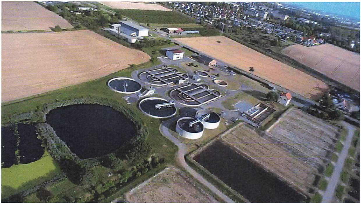
Die Kläranlage von Aschersleben aus der Vogelperspektive
